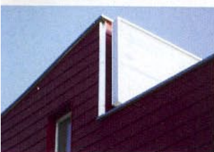
Zwei wesentliche Merkmale des Bermatinger Passivhauses: Die Holzbauweise und die Solarkollektoren
