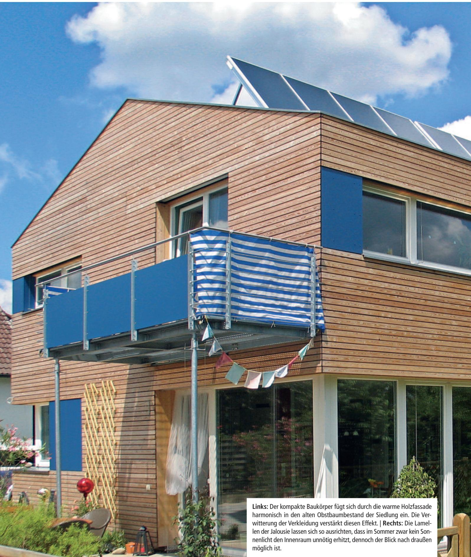
**Links:** Der kompakte Baukörper fügt sich durch die warme Holzfassade harmonisch in den alten Obstbaumbestand der Siedlung ein. Die Verwitterung der Verkleidung verstärkt diesen Effekt. | **Rechts:** Die Lamellen der Jalousie lassen sich so ausrichten, dass im Sommer zwar kein Sonnenlicht den Innenraum unnötig erhitzt, dennoch der Blick nach draußen möglich ist.
